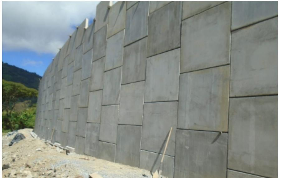
Muros en tierra armada: Diseñamos y construimos muros en tierra armada o suelo reforzado en los puntos específicos que el terreno con sus condiciones geológicas y topográficas lo permitieron. Se usó suelo de excavación, evitando el mayor consumo de materiales de construcción como cemento.
