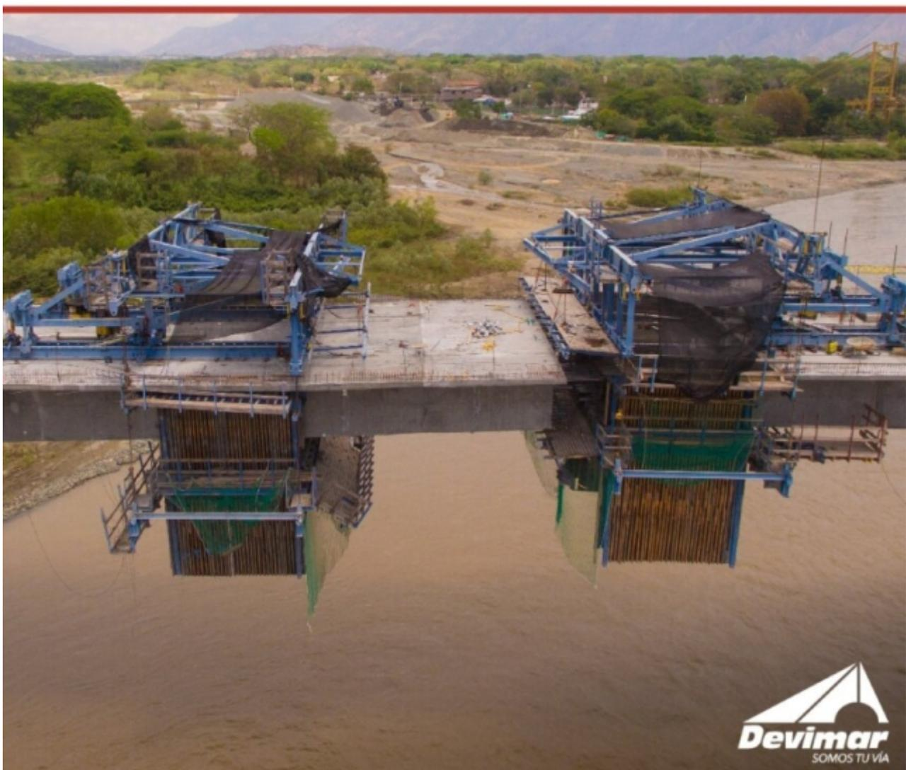
El nuevo puente, situado sobre el río Cauca en los municipios de Sopetrán y Santa Fe de Antioquia, resalta por sus dimensiones. Esta obra tiene una longitud de 426 metros y está compuesto por dos carriles viales, cada uno con un ancho de 3.65 metros, lo que resulta en un ancho total de 11.6 metros. Además, se sostiene sobre 7 robustos pilares y ha sido equipado con sistemas de aislación sísmica para garantizar una mayor seguridad.
