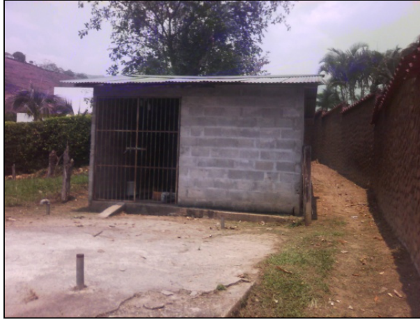
Fotografía 5-48 Planta de tratamiento, vereda El Rincon
