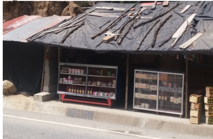
Fotografía 5-61 Negocio Informal localizado sobre la vía existente- Autopista al Mar.
