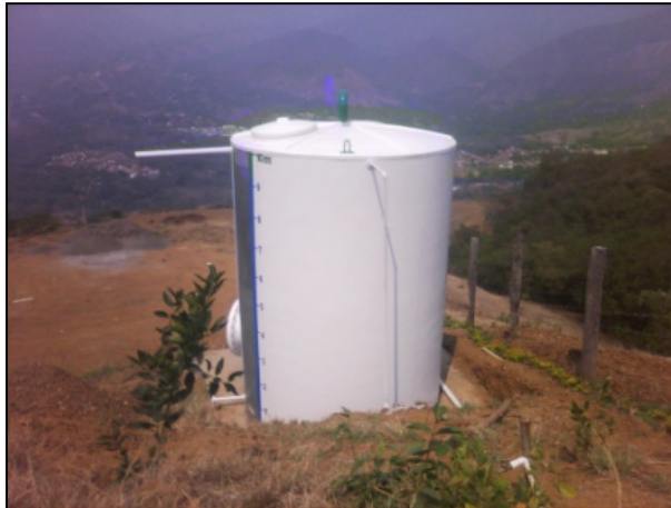
Fotografía 5-49 Tanque de almacenamiento vereda Loma Hermosa
