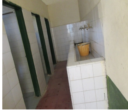
Fotografía 5-54 Unidad Sanitaria institución educativa Los Almendros.
