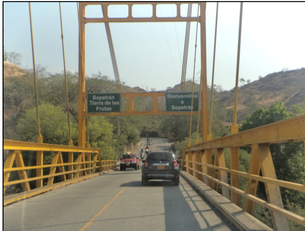
Fotografía 5-36 Infraestructura vial en el municipio de Sopetrán
