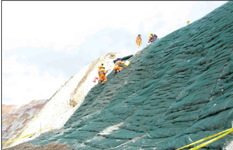
Fotografía 11-3 Vista de Proceso de Hidrosiembra
