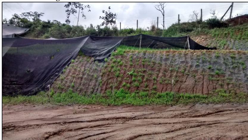
Fotografía 11-2 Vista de Proceso de Hidrosiembra
