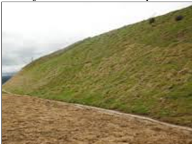
Fotografía 11-5 Vista de un talud empedrado
