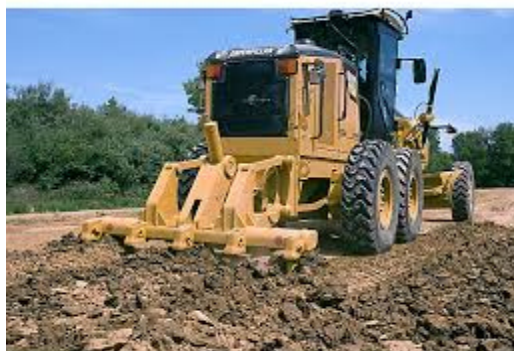
Fotografía 11-8 Proceso de escarificación mecánica del suelo
