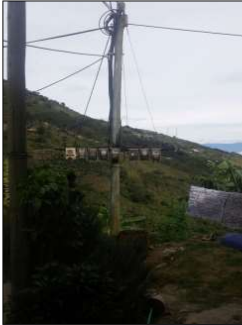
Fotografía 5-86 Poste de Energía con medidores Vereda Volcana-Guayabal
