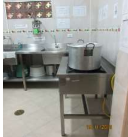
Fotografía 5-102 Dotación de la cocina 2 restaurante escolar estudiantes primaria
