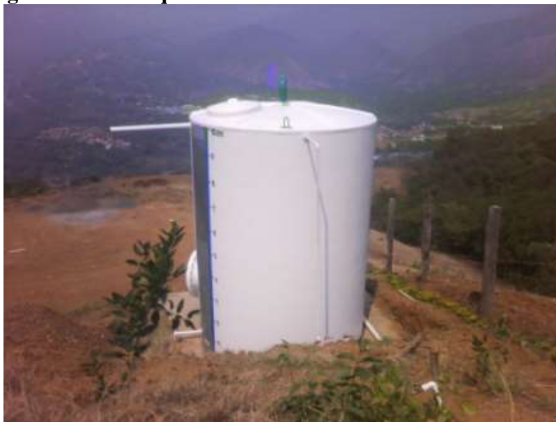
Fotografía 5-91 Tanque de almacenamiento vereda Loma Hermosa
