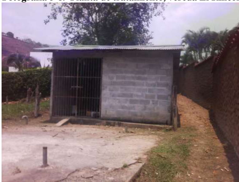
Fotografía 5-89 Planta de tratamiento, vereda El Rincon
