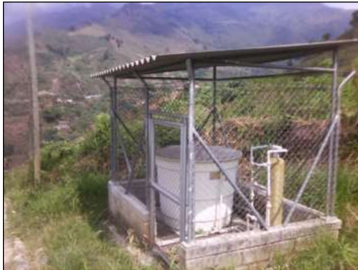
Fotografía 5-82 Tanque de almacenamiento, acueducto Vereda La Frisola
