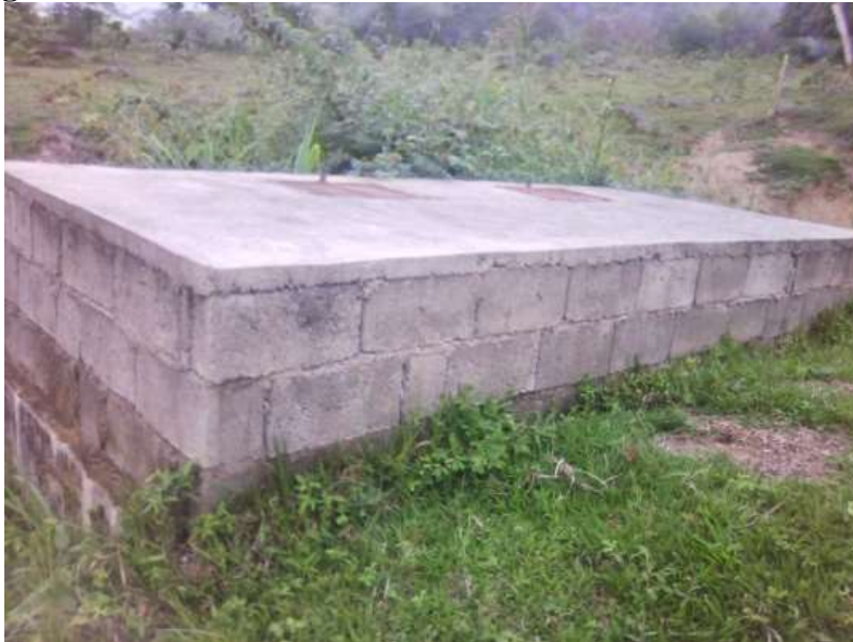
Fotografía 5-90 Desarenador del acueducto Vereda Llano San Juan
