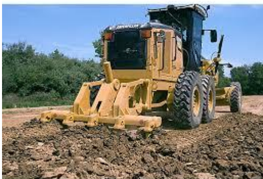
Fotografía 11-15 Proceso de escarificación mecánica del suelo
