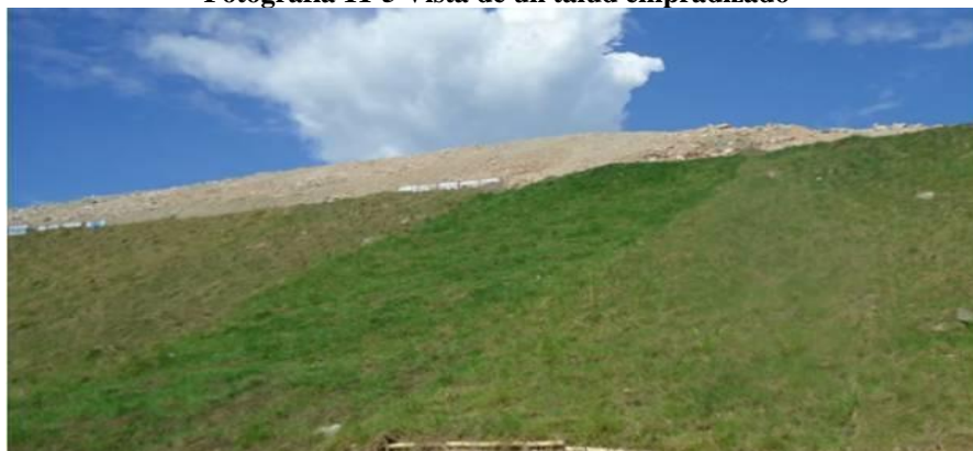
Fotografía 11-5 Vista de un talud empradizado
