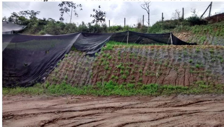
Fotografía 11-2 Vista de Proceso de Hidrosiembra
