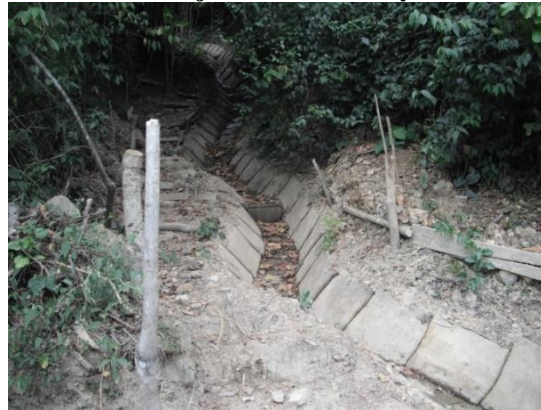
Fotografía 11-1 Vista de Zanja de Coronación y un Dren de Penetración
