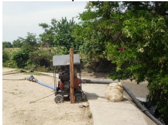
Fotografía 11-11 Esquema tipo de captación de agua por motobomba (estación de bombeo con equipo portátil).
