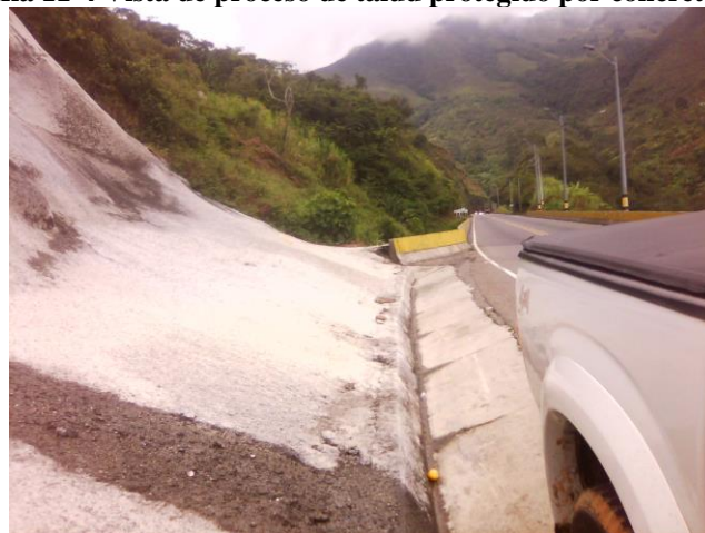
Fotografía 11-4 Vista de proceso de talud protegido por concreto lanzado
