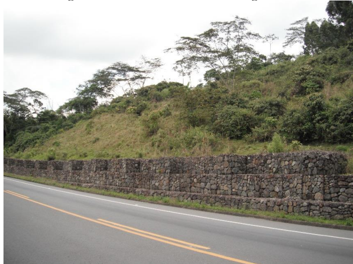
Fotografía 11-6 Vista de un muro de gaviones vía
