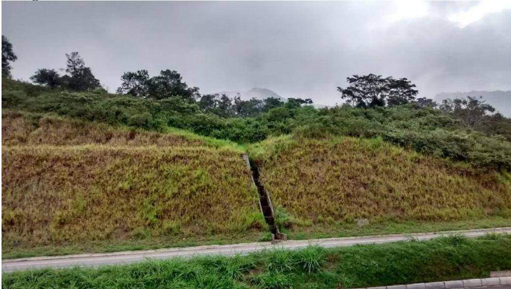
Fotografía 11-10 Vista de un descole de un sistema de cunetas colocadas en un corte vial
