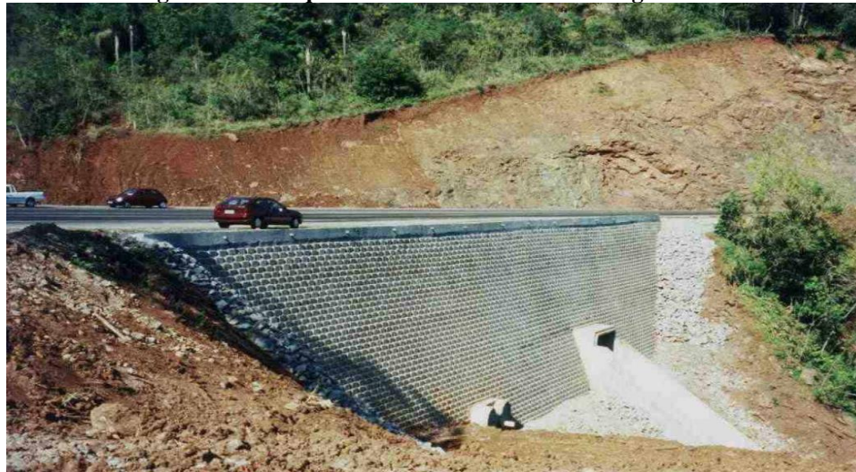
Fotografía 11-9 Esquema de muros reforzados con geosintéticos
