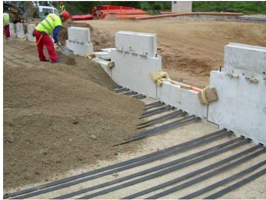
Figura 3-17. Ejecución de muro mediante suelo reforzado con placas de concreto
