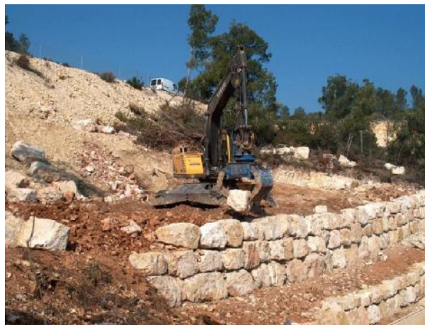
Fotografía 3-1. Muro de escollera
