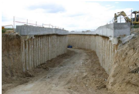
Fotografía 3-3. Muro pantalla de pilotes
