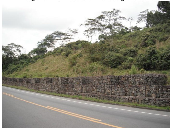
Fotografía 11-6 Vista de un muro de gaviones vía
