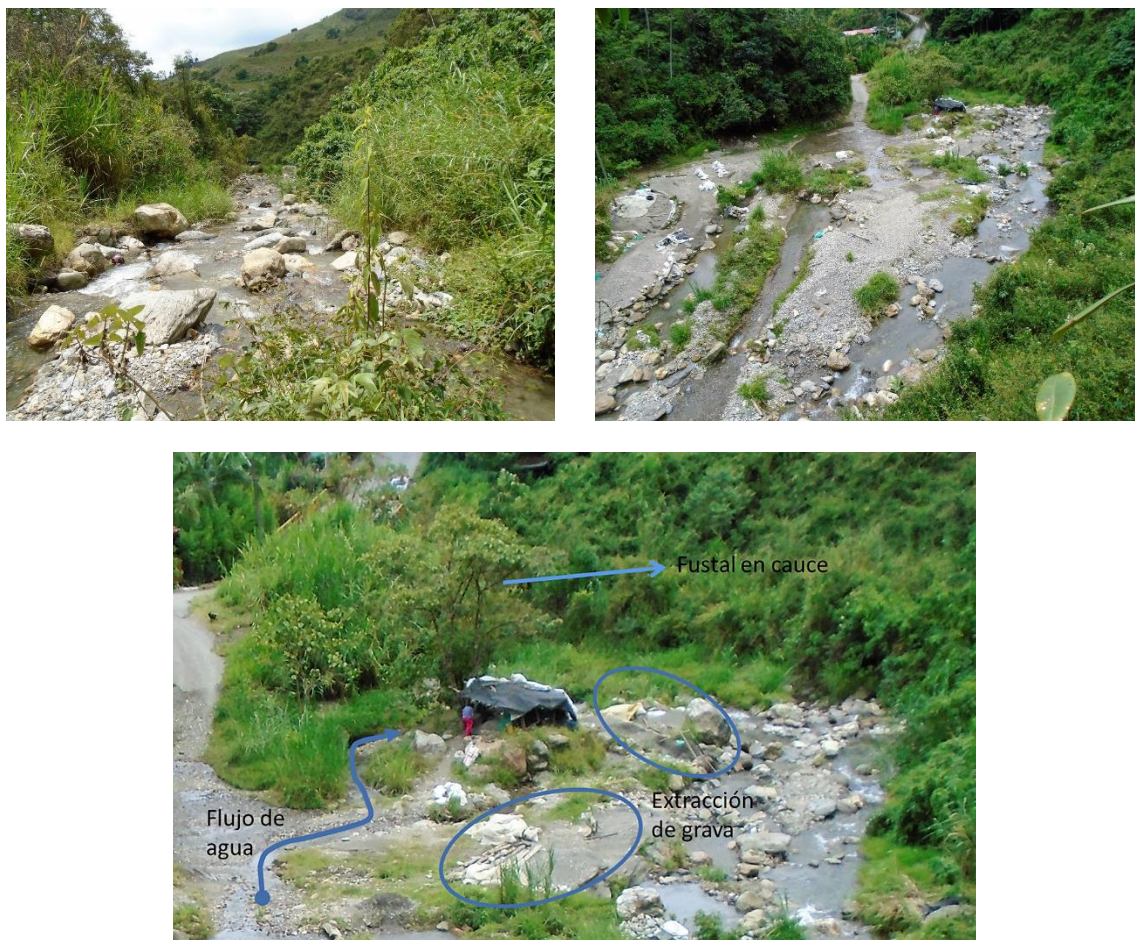
Fotografía 5.4 Cobertura Rio (R)
