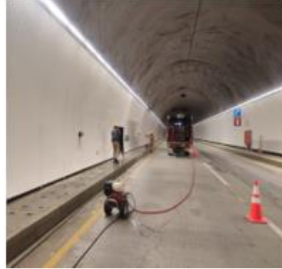
PR41+00 TÚNEL 2 UF 3
