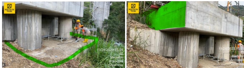
Inicio actividades reforzamiento Puente La Frisola
