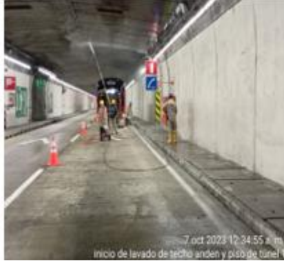
PR 43+200 TÚNEL 1 UF 3
