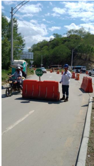
Control tráfico Puente Paso Real
